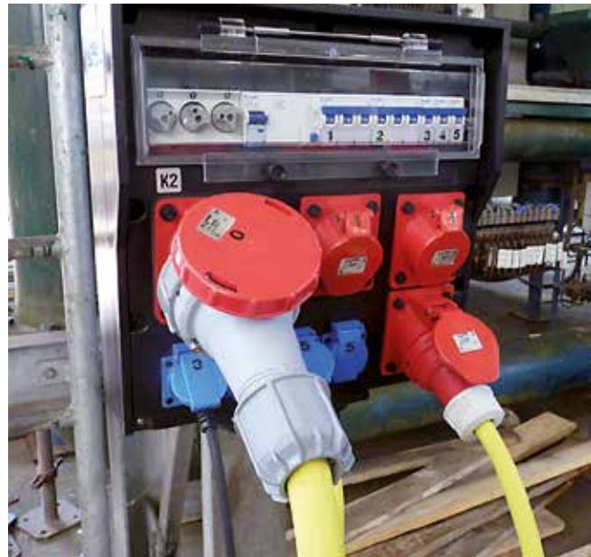
Bild 5-32: Steckvorrichtungen für erschwerte Bedingungen
