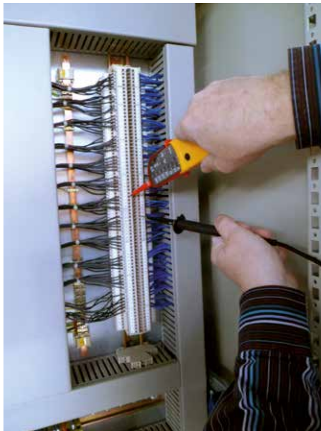
Bild 5-15: Feststellen der Spannungsfreiheit mit vorschriftsmäßigem Spannungsprüfer
