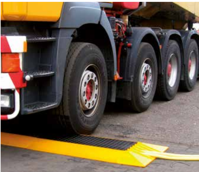
Bild 5-28: Schutz von Baustellenkabeln auf Verkehrswegen
