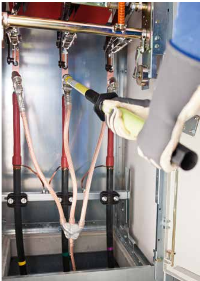
Bild 5-18: Erden und Kurzschließen nur mit kurzschlussstromfester Leitungsgarnitur
